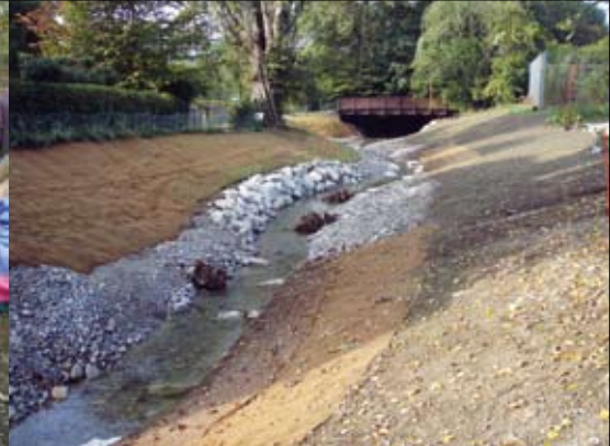
Travaux entre la passerelle Gautier et la rte de Chêne-Bougeries
