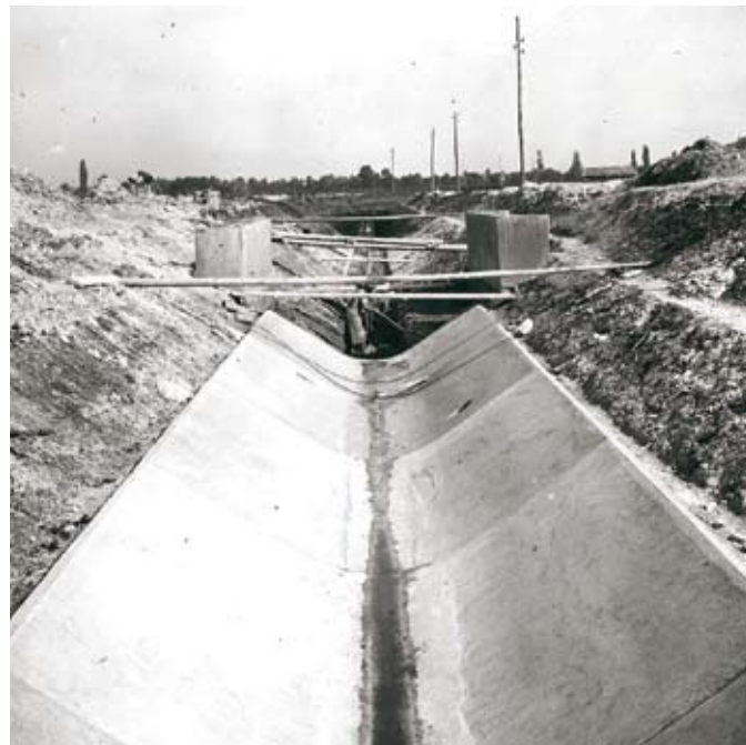
Travaux de canalisation (de 1915 à 1920)
