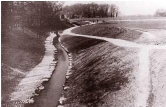
Photo après travaux (aval du pont Bochet, 1982)
