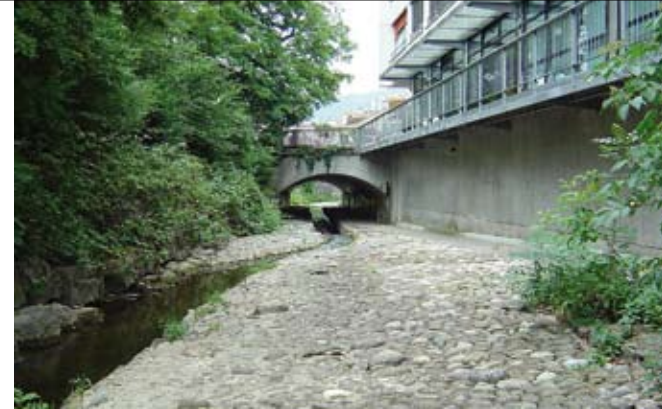
Seymaz urbaine : lit de boulets bétonnés
